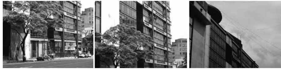
Figura 12A. Edificio SOMISA: Nivel de acceso, plantas intermedias y volúmenes de remate en la terraza.
