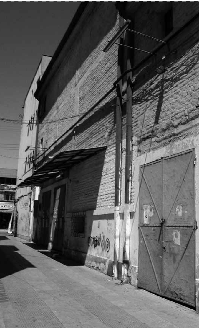
Actual acceso desde el pasaje privado, al norte del predio.
