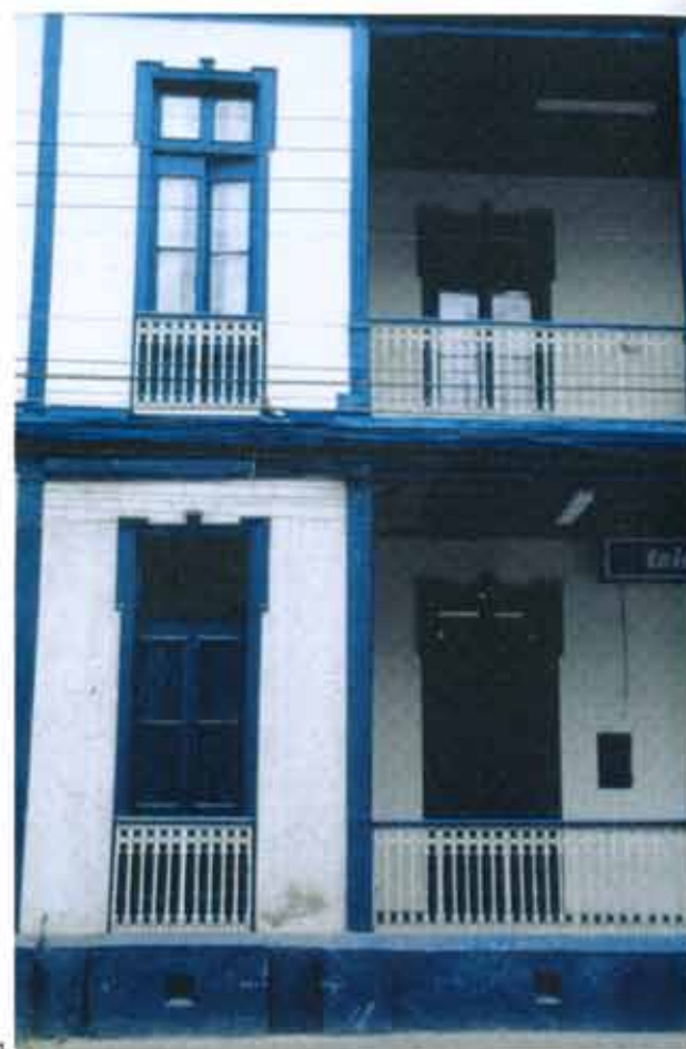
3. y 4. Casa habitación-reciclada para servicio de transporte, con Balcones Antepechados sobresalientes del muro, ubicada en San Martín N°290, frente a la Plaza de Quillota. 5. Edificio de oficinas, que utiliza el Balcón Sobresaliente de Mazorca para ventanas de 10 pisos de altura. Ubicado en Avda. B. O'Higgins esquina de Nueva York, Santiago de Chile, en terminaciones en 1995. Arqts. Swinburn, Pedraza y Alegria.
