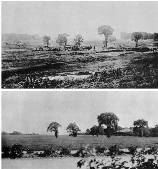
FIGURA 4 Comparativa entre los trabajos de nivelación en el Playstead de Franklin Park, Boston (1887) y el estado final de la obra. Frederick Law Olmsted
